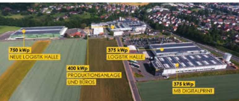
Übersicht der Photovoltaikanlagen der REINHOLD KELLER Group, Kleinheubach
