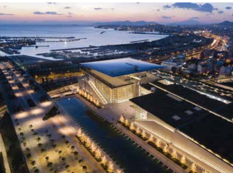
Griechische Nationaloper mit begehbaren BiPV-Modulen
