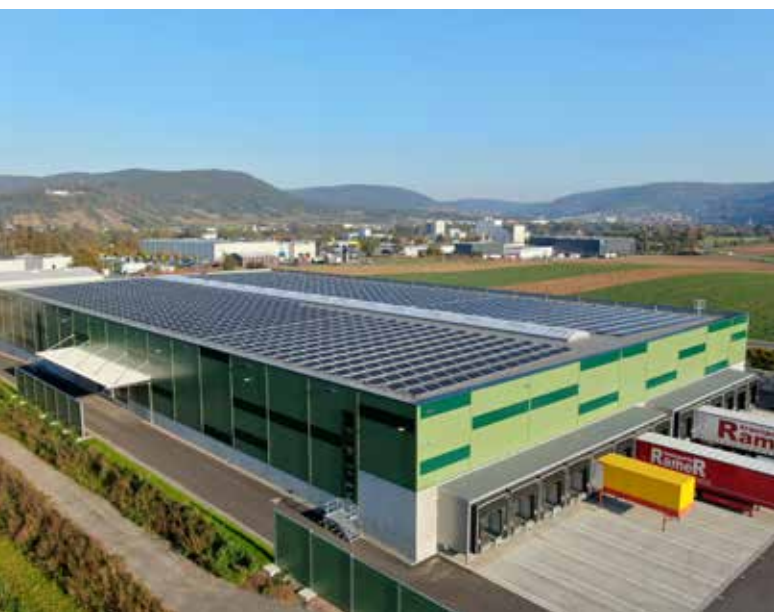
Neubau Logistikhalle Kleinheubach: Dach und Fassade (Bildnachweis: News Verlag)
