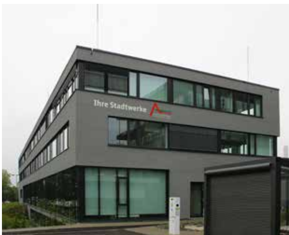
AVG-Gebäude mit LoRaWAN Antennen
